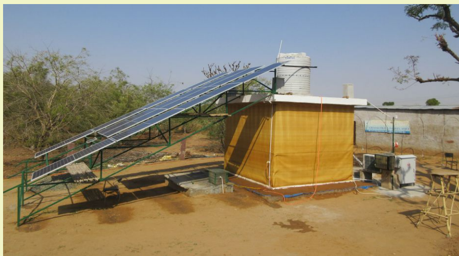
राजस्थान के अजमेर के पिचौलिया गांव में सफलतापूर्वक परिचालित पूसा-फार्म सनफ्रिज – एक ग्रिड रहित, बैटरीहीन शीत भंडारण प्रणाली
